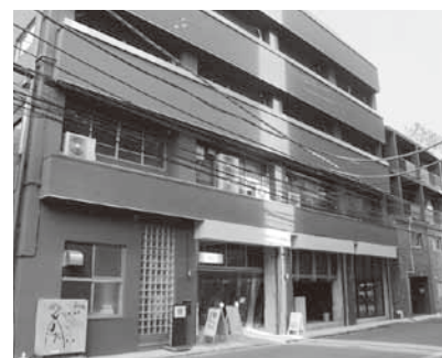
複合施設にリノベーションしたビル
